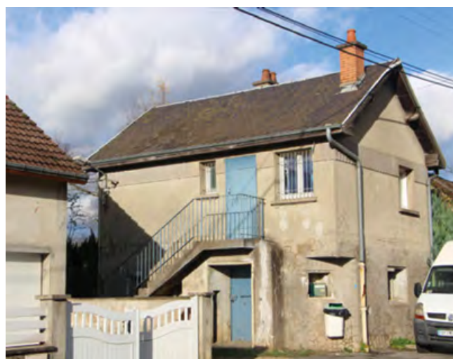
La maison forte
